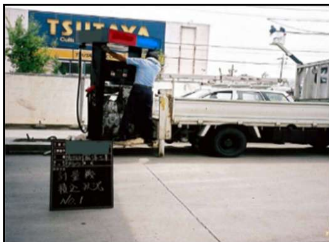
・計量機撤去中
