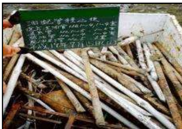
* 車両に配管を積込した写真は必要
